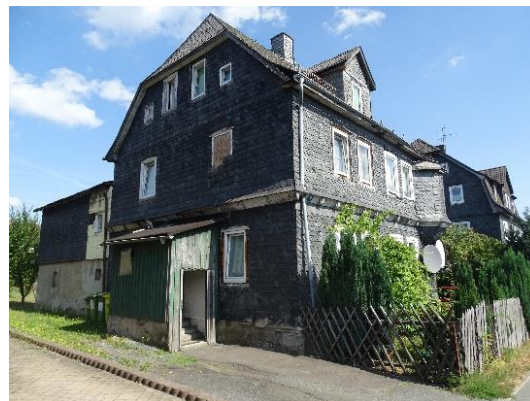
Abb. 44: Ortsbildprägende Einzelgebäude in „Steinbach-Bahnhof“
