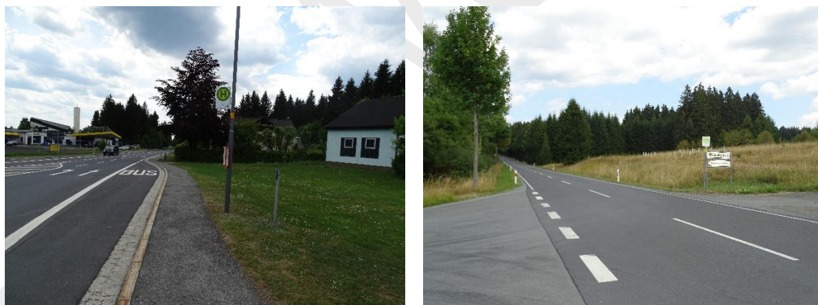
Abb. 93: Bushaltestelle Kreisverkehrsplatz „B85“ (links), Bushaltestelle Abzw. Bauschuttdeponie (rechts)
