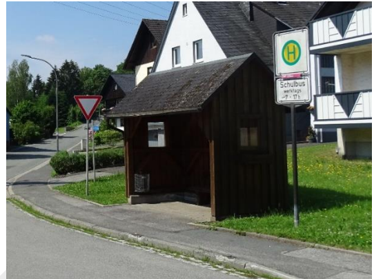
Abb. 50: Bushaltestelle am Wehrkirchpark
