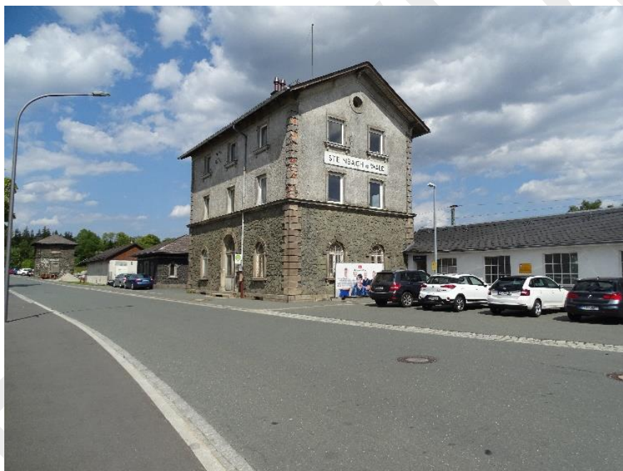
Abb. 33: Leerstehendes Empfangsgebäudes des Bahnhofes Steinbach am Wald
