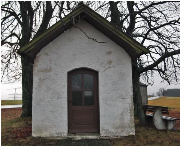
Wegekappelle vor der Sanierung
