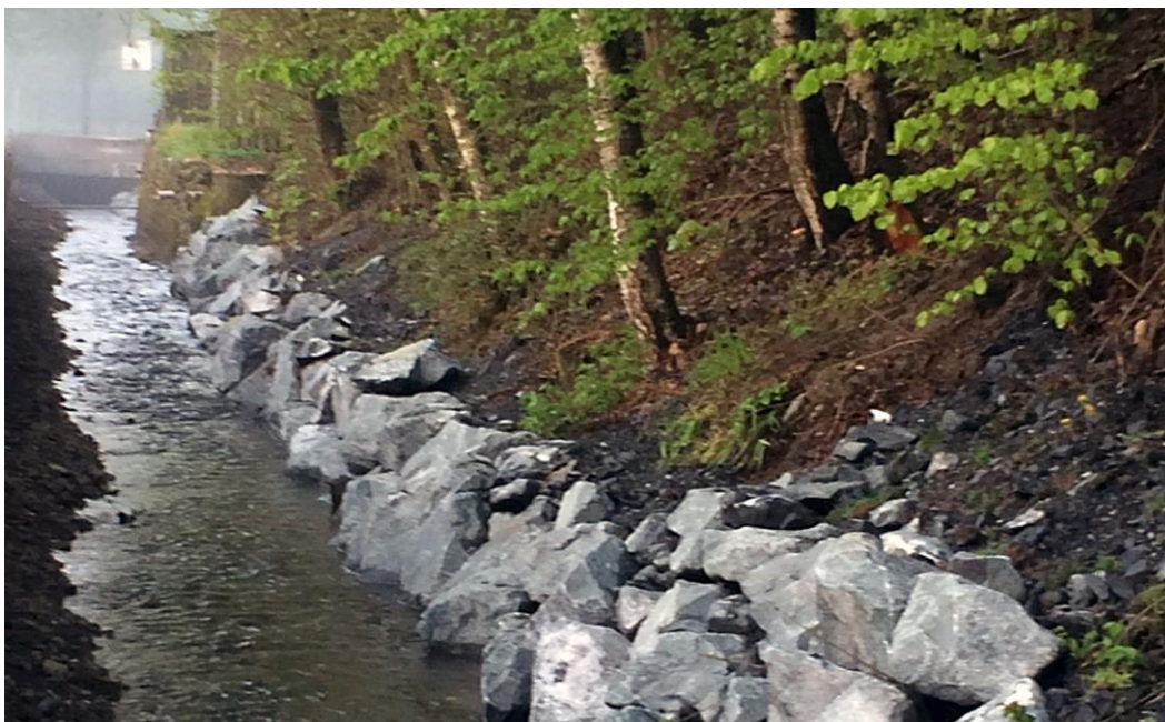
Neue Uferbefestigung Ölschnitz
